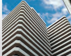
NIX (THAILAND) LTD.
