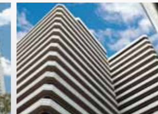
NIX (THAILAND) LTD.
