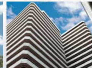
NIX (THAILAND) LTD.
