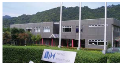
グローバル生産本部（生産拠点）
